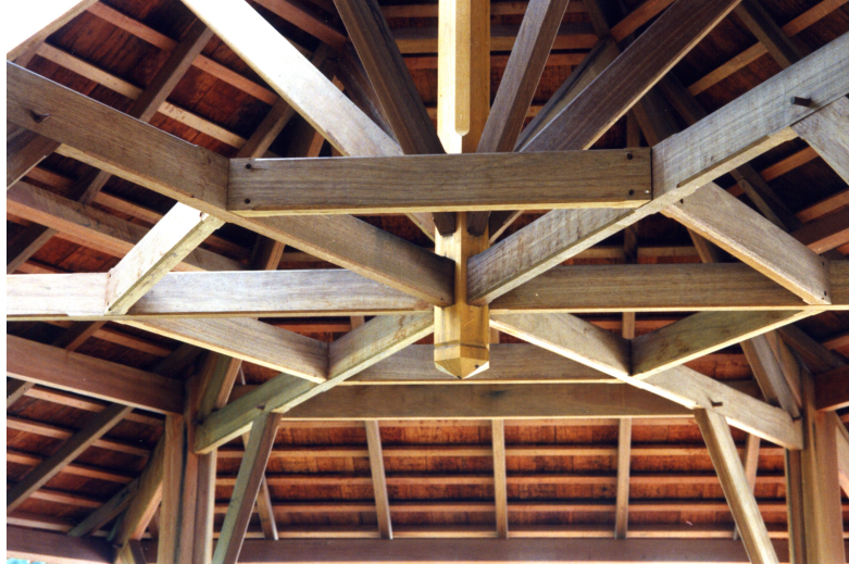
Charpente traditionnelle en Basralocus et bardeaux en Wallaba - Kourou (Guyane française)
